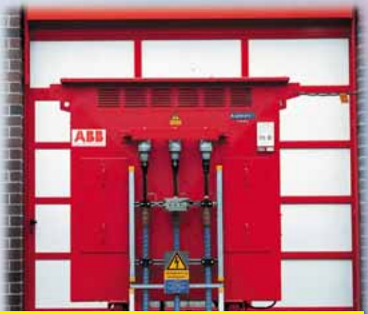
Трансформатор с кожухом для наружной установки
